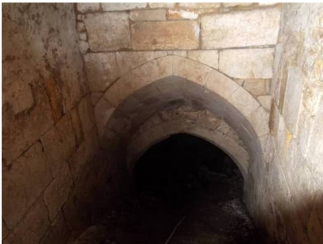
Entrée souterraine de la salle
